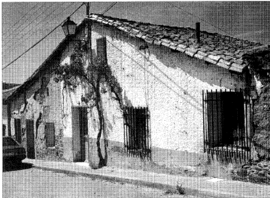
Vivienda situada en la calle de la Fuente, 13
