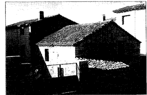
Conjunto de construcciones rurales en la calle del Arroyito. Detalle de una de las dependencias auxiliares
