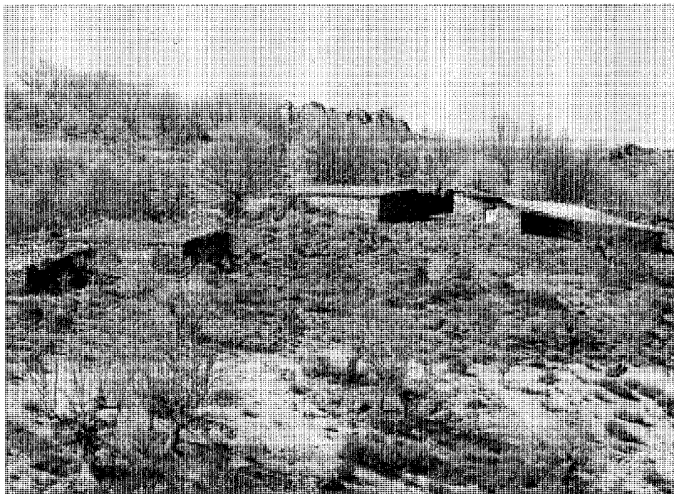
Tinados de la Hoyadilla. Vista general
