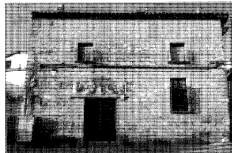
Calle Burgos, 3 c/v Montera. Fachada principal
