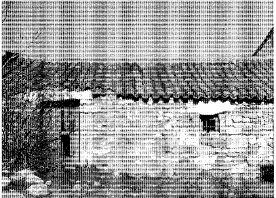
Edificación auxiliar agropecuaria. Calle de la Venta
