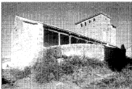
Iglesia de Santo Domingo de Silos. Vista desde el ángulo sudeste
