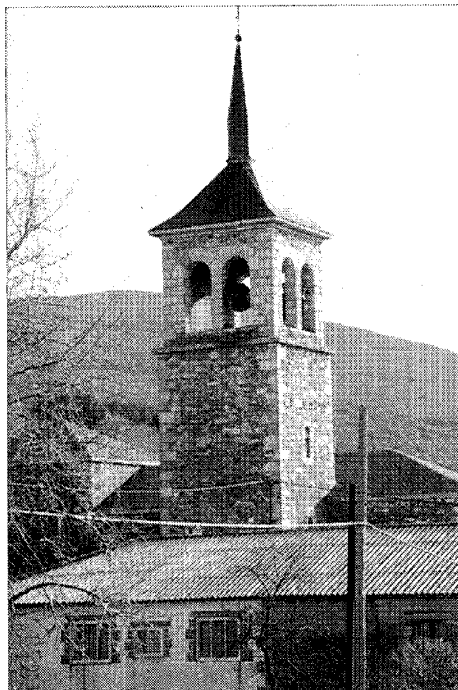
Vista de la torre
