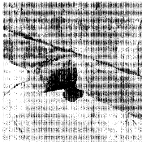
Detalle de desagüe del tablero
