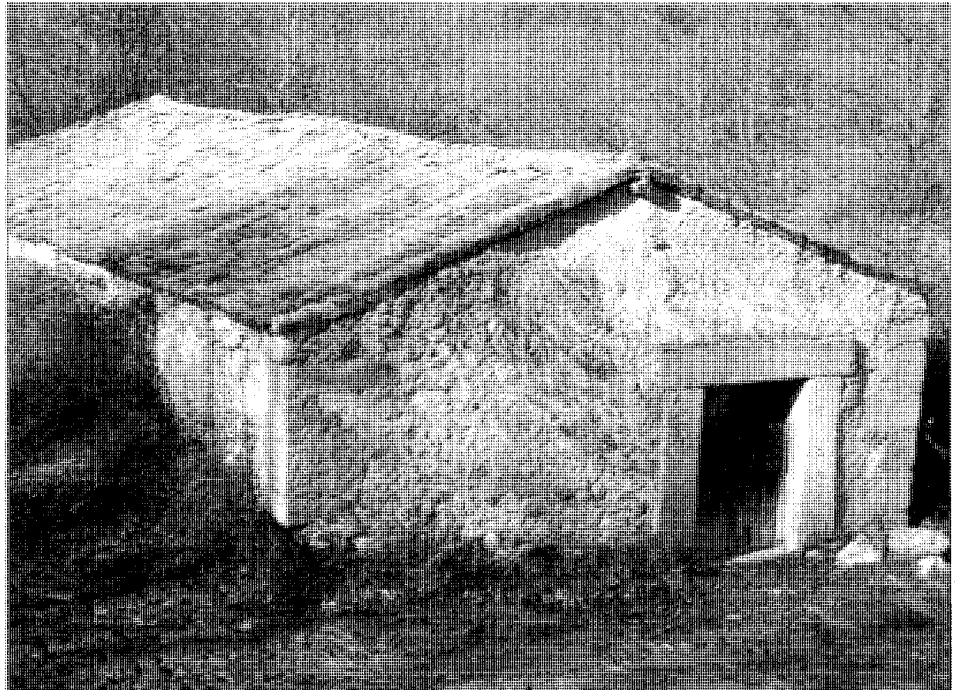
Molino de Briscas. Vista general
