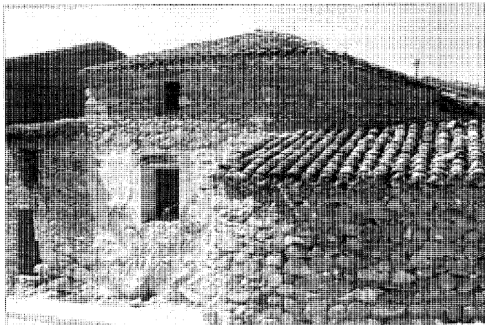
Antigua construcción de mampostería en el Vellón. Calle Bodeguilla c/v Parra
