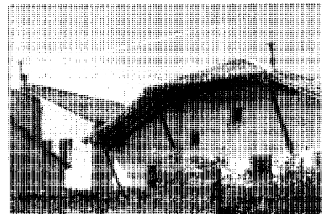
Detalle del alero de la fachada principal
