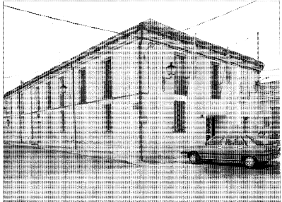
Vista general del edificio
