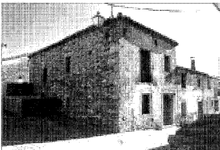
Paredes de Buitrago. Vivienda en la calle Luna c/v Calleja de la Fuente
