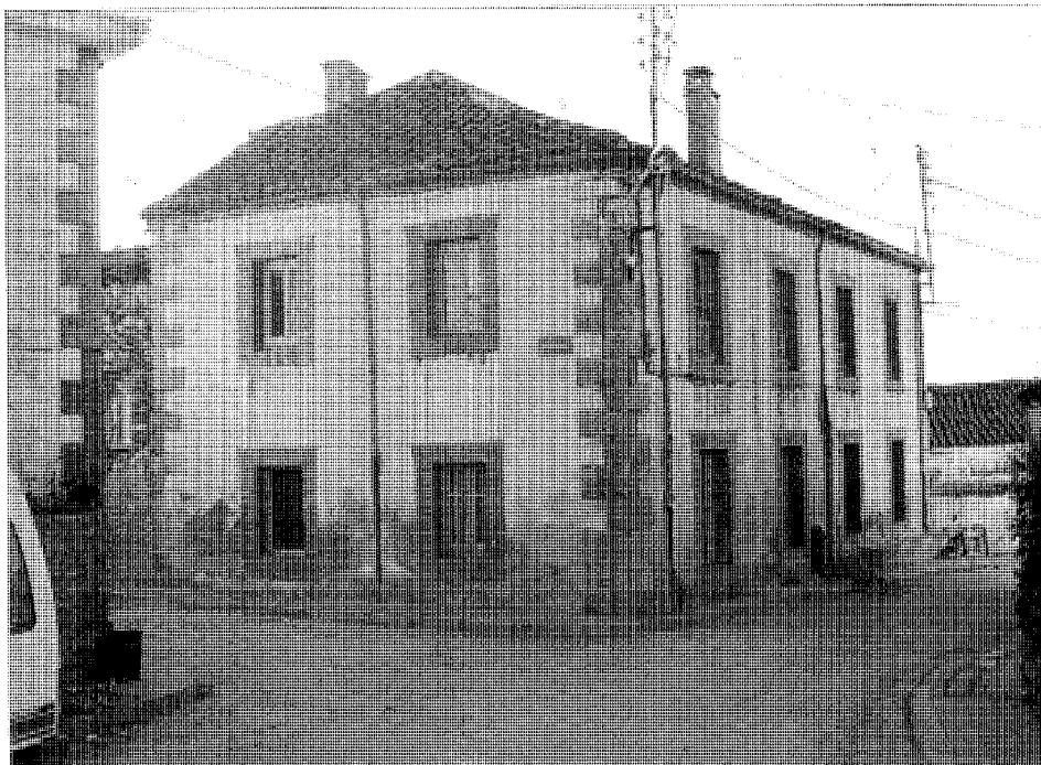
Casa en la calle Peligros
