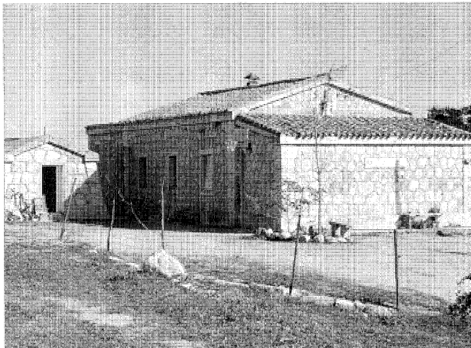
Casilla del Canal Alto de Isabel II. Vista general
