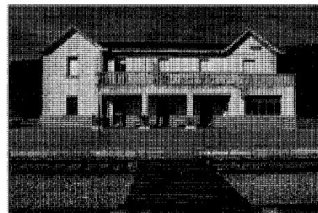
Estación de Robregordo-Somosierra. Vista frontal
