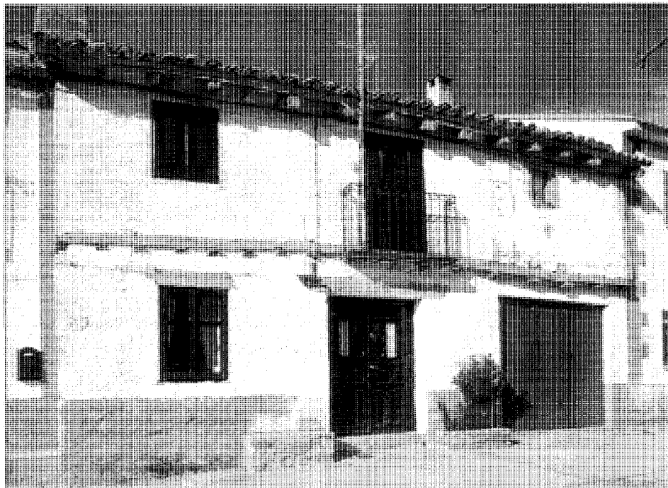
Vivienda en la calle Real
