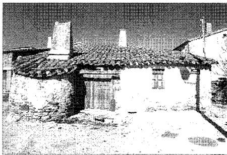
Paredes de Buitrago. Ejemplo en la calle Esquinilla
