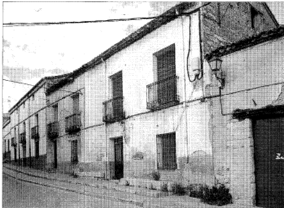
Fachadas delanteras a la calle Félix Sanz
