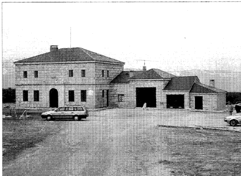
Albergue de la Morcuera. Fachada principal
